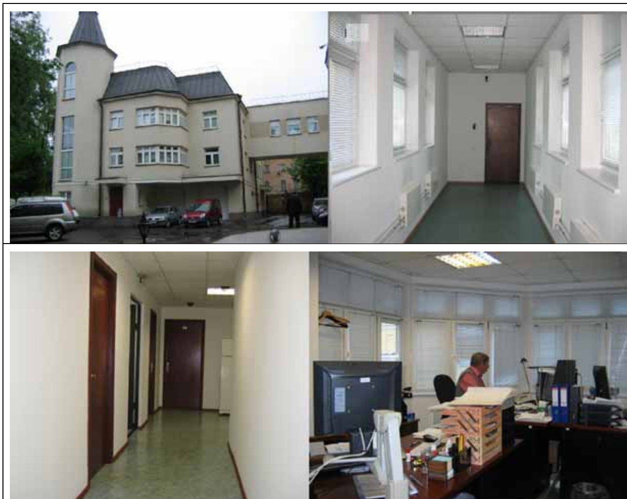
Рис. 15.3 Внешний вид здания ул. Погодинская, д.24, стр.2
