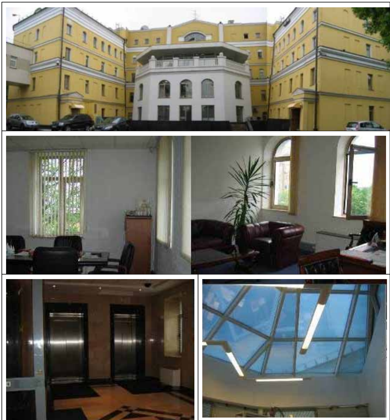
Рис. 15.2 Внешний вид здания ул. Погодинская, д.24, стр.1
